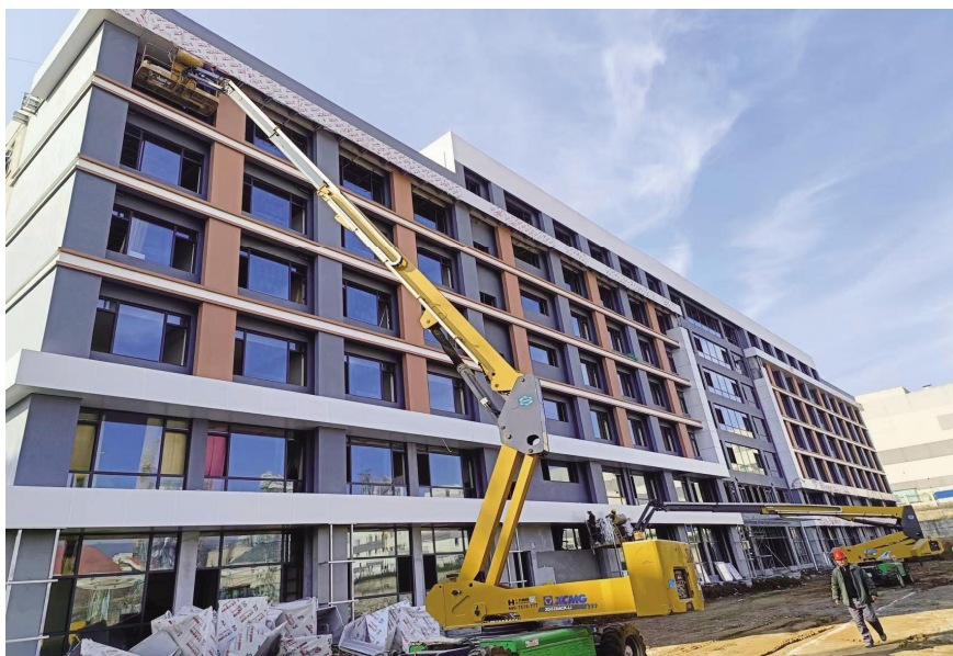
郊区 2025 年人大代表票决民生实事——人才公寓项目建设现场。
